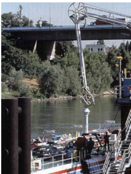
Poste de déchargement de l'usine ATOFINA, Saint-Fons (photo VNF) Le gaz liquéfié (matière première du PVC) est directement acheminé à l'usine ATOFINA par voie fluviale. Un appontement équipé de structures de déchargement, est implanté sur les berges de Saint-Fons. L'équipement respecte les normes de sécurité les plus strictes.
