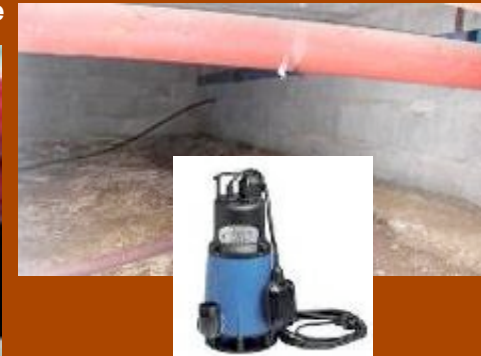
Drainage, pompage, aération et visibilité du vide sanitaire
