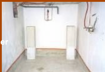
Cuvelage de cave
